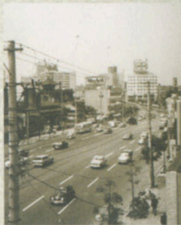
拡幅工事・区画整理した直後の青山通り。街路樹はこの時に植えられた。
